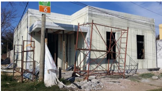
Vivienda en Paso de los Toros
